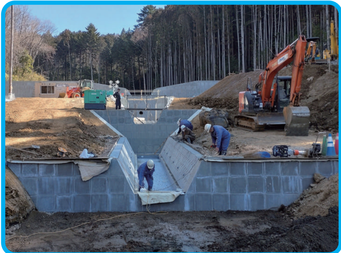
【黒羽地区砂防堰堤工事】土砂災害から住民の命と財産をまもりまします。
