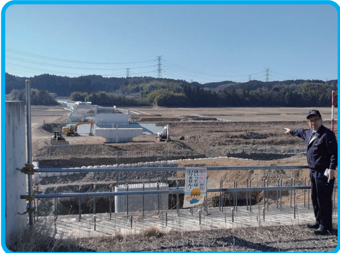
【親園 - 佐久山バイパス】令和 5 年度橋梁上部工事が開始します。今後ライスラインからの延伸工事の事業化を進めてまいります。
