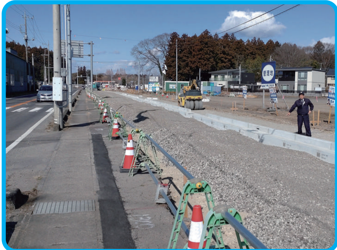
要望していた県管理国道 461 号 - 県道親園南金丸線交差点付近改良工事が現在進行中です。
